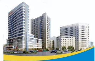
六安市人民医院 消毒供应中心
