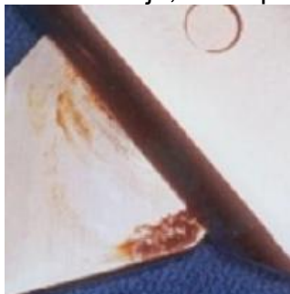
Trošenje površine i stvaranje korozije izazvano malim pomeranjima spojenih delova
