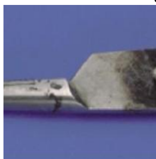
Tačkasta ili jamičasta korozija
